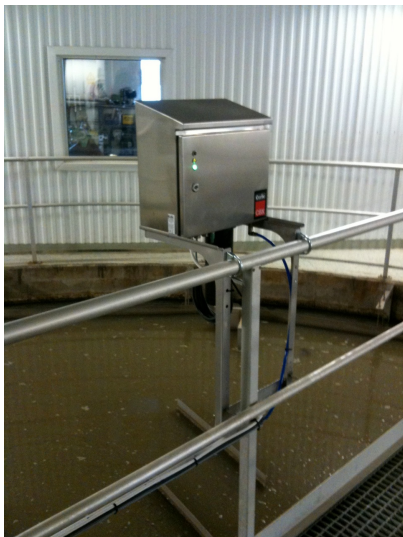
Installed Cerlic CBX in thickener at Mälarenergi, Kungsängsverket, Västerås, Sweden
